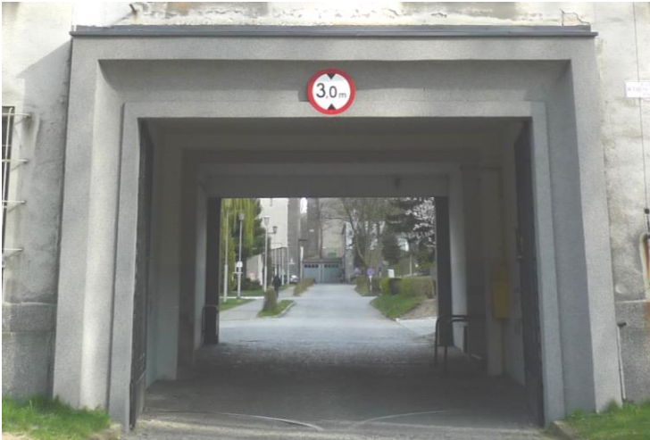
Fot. 39, 40. Profilowana opaska wokół otworu przejazdu pod budynkiem C3 wykonana z nietrwałego (zwłaszcza w miejscu narażonym otarcia tj. przejazd) marmurowego tynku mozaikowego widok od zach./wsch.
