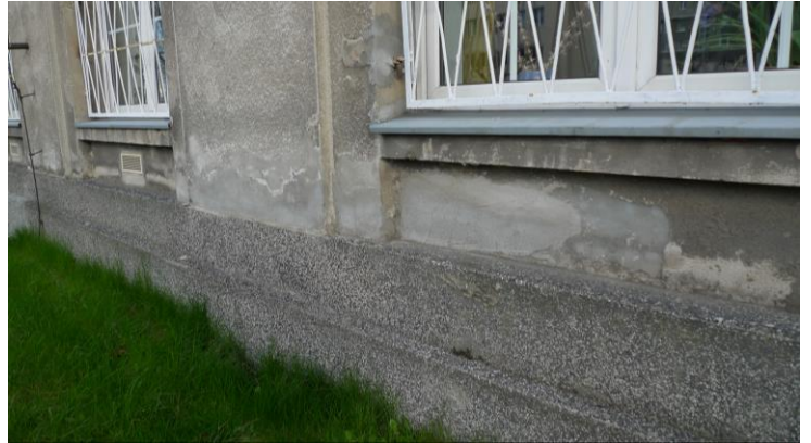
Fot. 35. Uszkodzenia tynku powyżej cokołu związane z zawilgoceniem ścian, widoczne zasolenia, elew. zach. skrzydła zach..(narożnik zach.-pd.)
