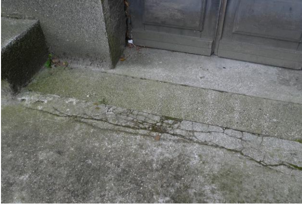
Fot. 32. Pęknięcie płyty spocznika schodów zewnętrznych w pn.-zach. narożniku między budynkami C2 i C3.
