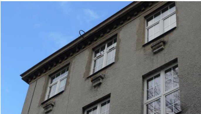
Fot. 27. Widoczna różnica tynku wokół okien najwyższej kondygnacji związana z przemurowaniem otworów okiennych, elew. zach. gmachu gł.
