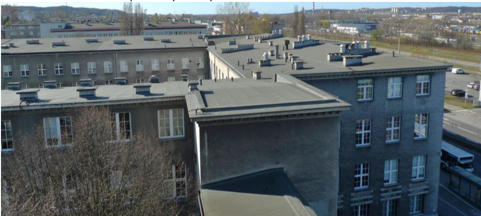
Fot. 46. Dach budynku C2 oraz północne partie C1 i C3 – pokrycie w dobrym stanie, po niedawnym remoncie.
