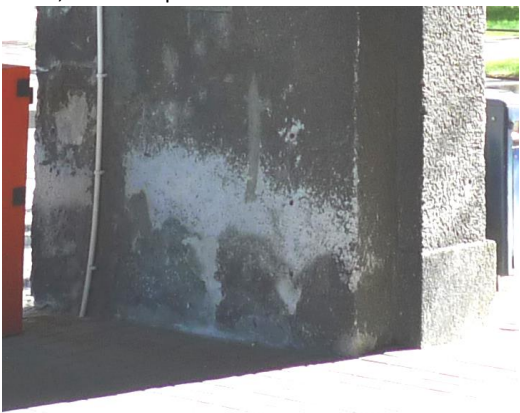
Fot. 24., 25. Wykwity solne w dolnych partiach filarów przejazdu bramnego.
