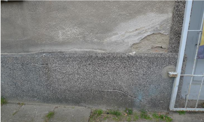
Fot. 37. Uszkodzenia tynku powyżej cokołu związane z zawilgoceniem ścian, widoczne zasolenia, elew. wsch. skrzydła zach.
