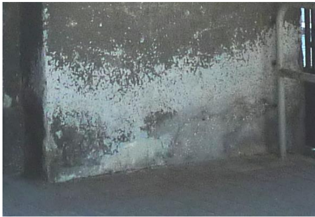
Fot. 24., 25. Wykwity solne w dolnych partiach filarów przejazdu bramnego.
