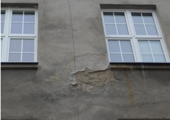
Fot. 41. Ubytek tynku w okolicy parapetu okna trzeciej kondygnacji związany z zaciekaniami wody opadowej, elewacja wschodnia skrzydła zach.
