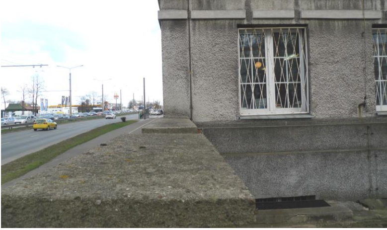
Fot. 30. Brak spadku na czapach słupków ogrodzenia budynku od strony zach.
