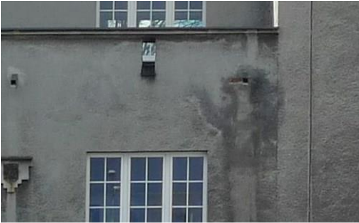
Fot. 22. Zaciek na attyce niższej części przejazdu bramnego elew. pn. świadczy o niewłaściwym (wcześniej ?) odprowadzaniu wody z tarasu.
