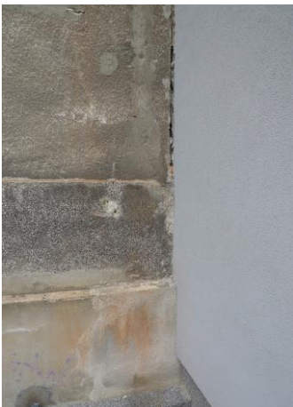
Fot. 43. Niewypełniona szczelina między budynkiem C1 a przylegającą do niego od pd. przybudówką, ściana C/E8, oś środkowa.
