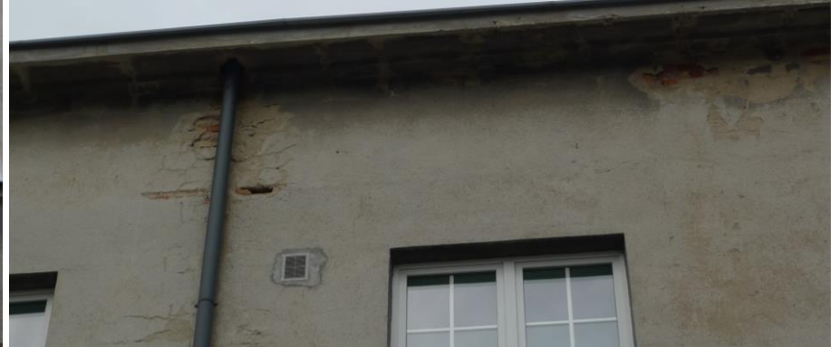
Fot. 41. Ubytek tynku w okolicy parapetu okna trzeciej kondygnacji związany z zaciekaniami wody opadowej, elewacja wschodnia skrzydła zach.
