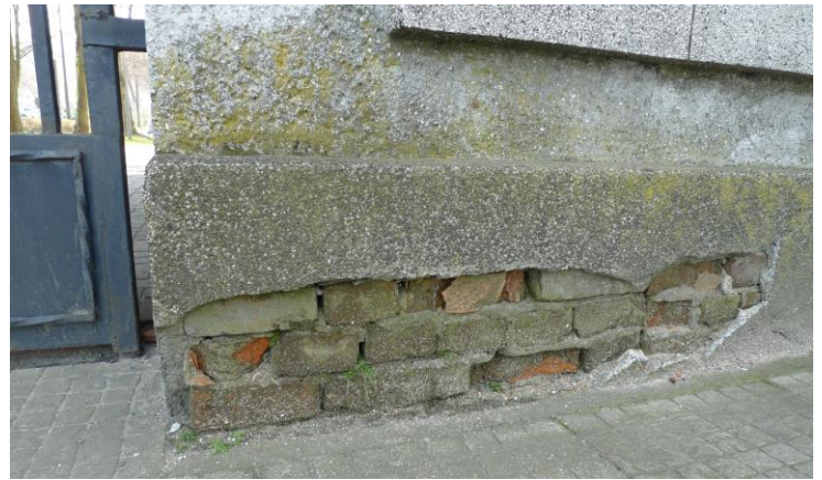
Fot. 22. Zaciek na attyce niższej części przejazdu bramnego elew. pn. świadczy o niewłaściwym (wcześniej ?) odprowadzaniu wody z tarasu.
