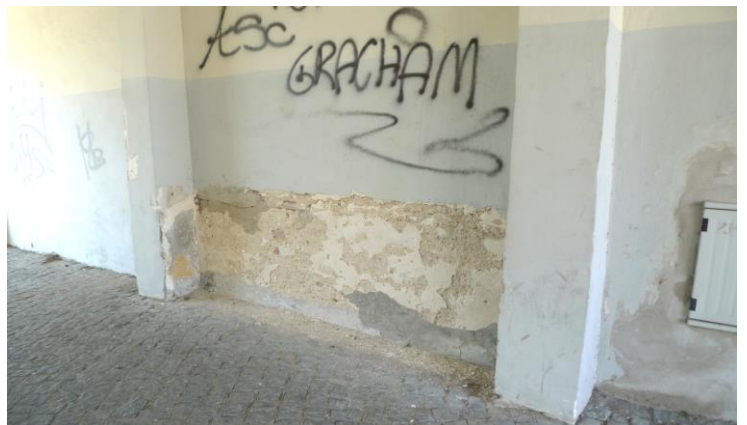
Fot. 37. Uszkodzenia tynku powyżej cokołu związane z zawilgoceniem ścian, widoczne zasolenia, elew. wsch. skrzydła zach.
