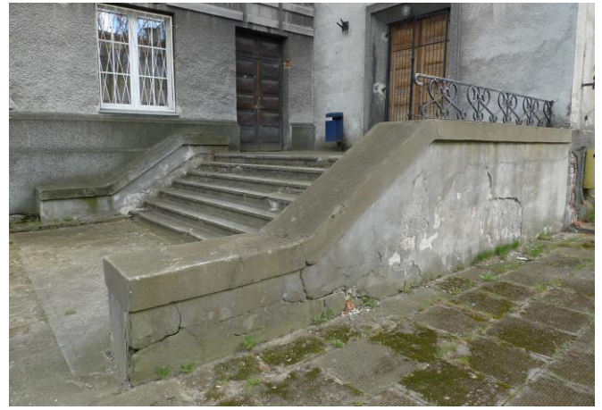
Fot. 31. Zawilgocony mur balustrady schodów z odpadającym tynkiem i śladami działalności mikroflory, widok od pn.-zach..
