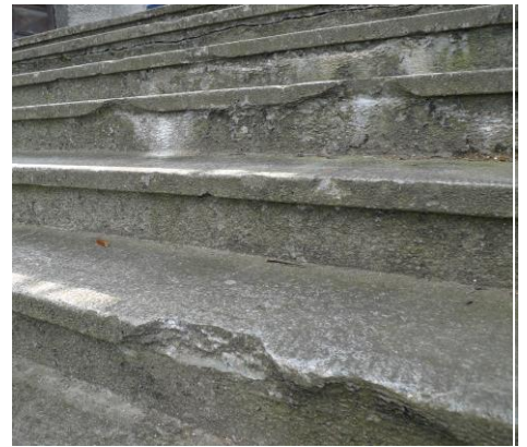
Fot. 33. Odpadający tynk w zawilgoconym narożniku muru budynku C3 i balustrady wywołany przez brak właściwego spadku spocznika schodów.
