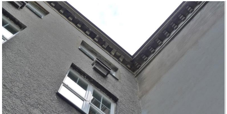
Fot. 27. Widoczna różnica tynku wokół okien najwyższej kondygnacji związana z przemurowaniem otworów okiennych, elew. zach. gmachu gł.
