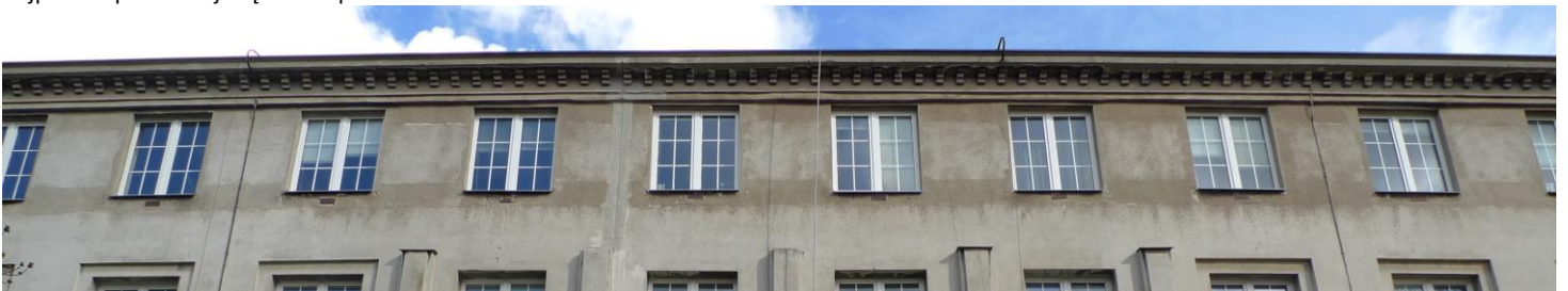
Fot. 29. Widoczna różnica tynku wokół okien najwyższej kondygnacji związana z przemurowaniem otworów okiennych, elew. zach. skrzydła zach.
