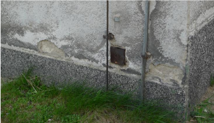
Fot. 35. Uszkodzenia tynku powyżej cokołu związane z zawilgoceniem ścian, widoczne zasolenia, elew. zach. skrzydła zach..(narożnik zach.-pd.)
